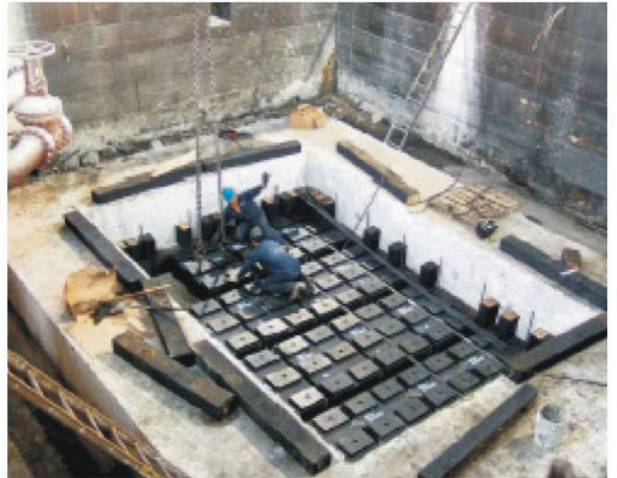
MRM™隔振单体被依次放入基础坑内
