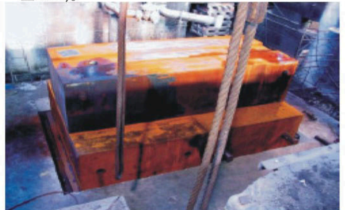
安放锻锤底部钢板，配重和砧座
