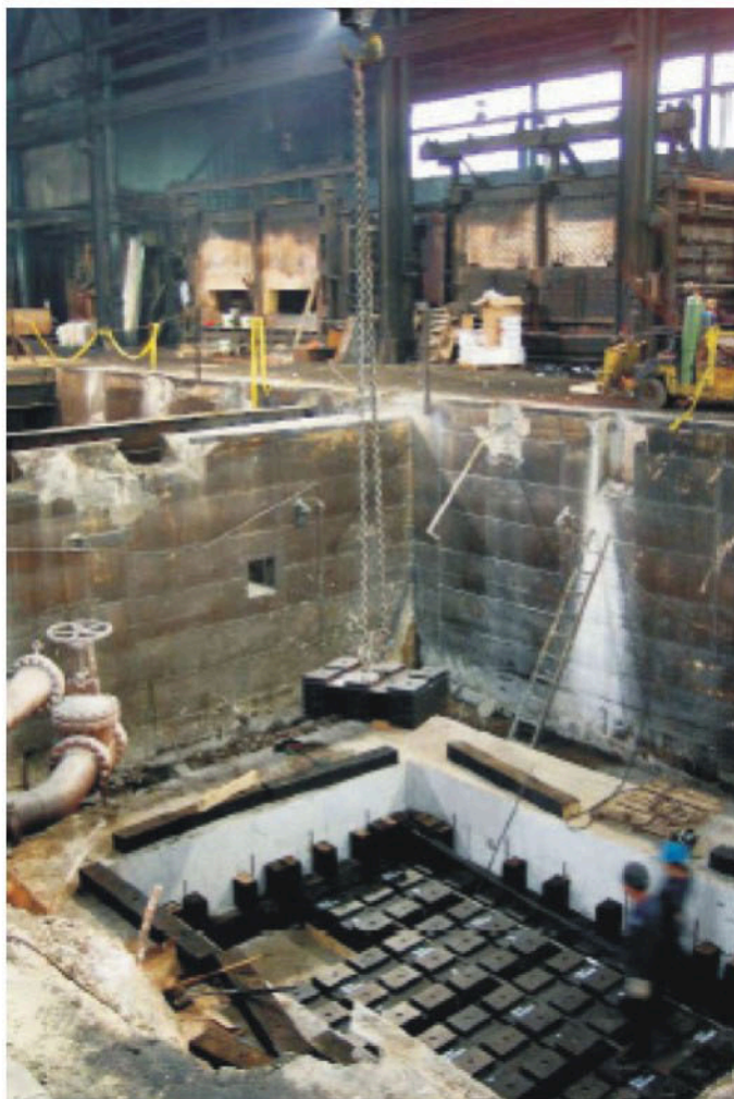
使用吊环，把MRM™隔振单体慢慢地并放入基础坑内
