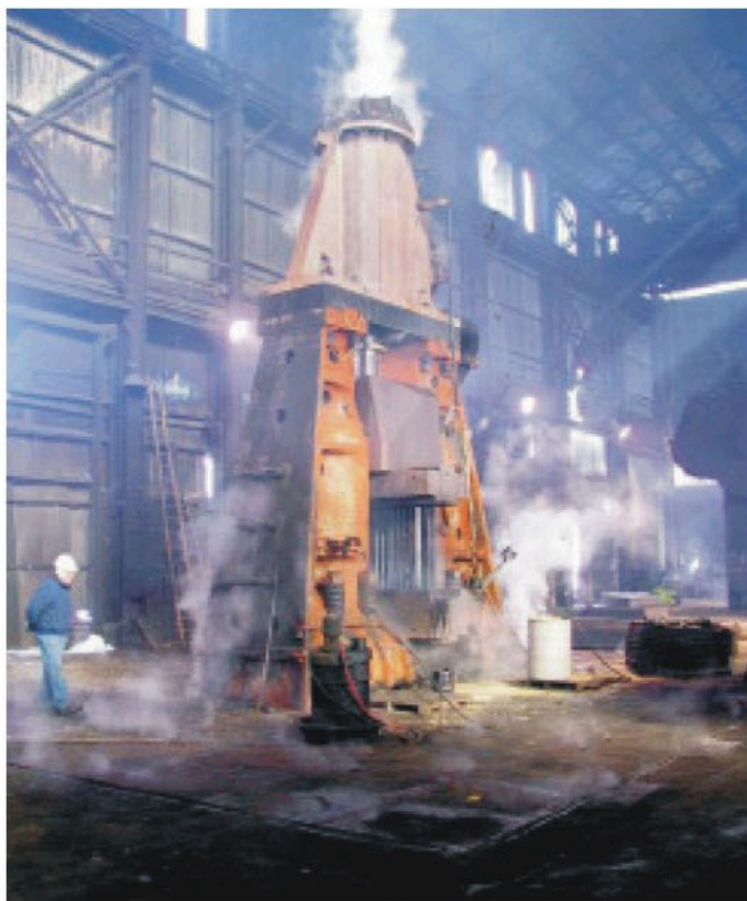
23吨(50, 000lb)Erie蒸汽锤安装完毕, 正在运行!
