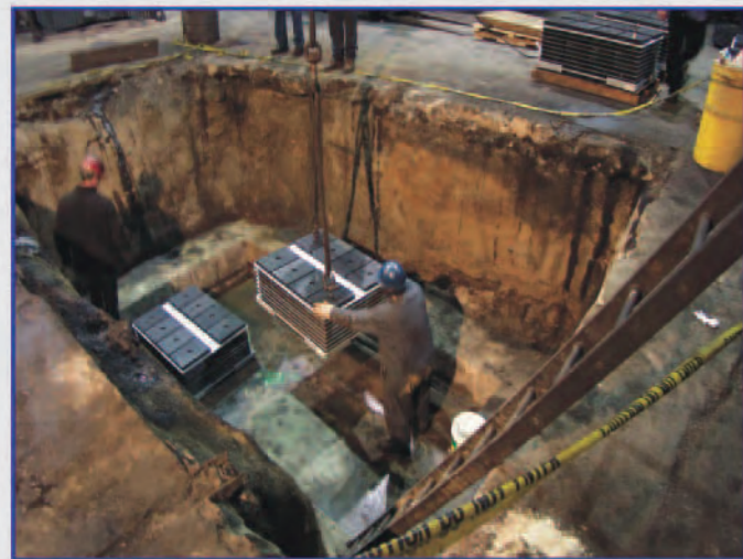
MRM™ 隔振单体被依次放入基础坑内
