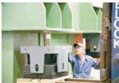
隔振器被提升到一台压力机机脚下。
