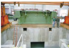
然后将带有隔振器的压力机机座安装在基础柱上。
