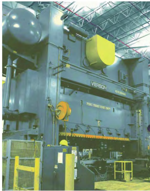
一共在5小时内完成压力机的调平和对中。
